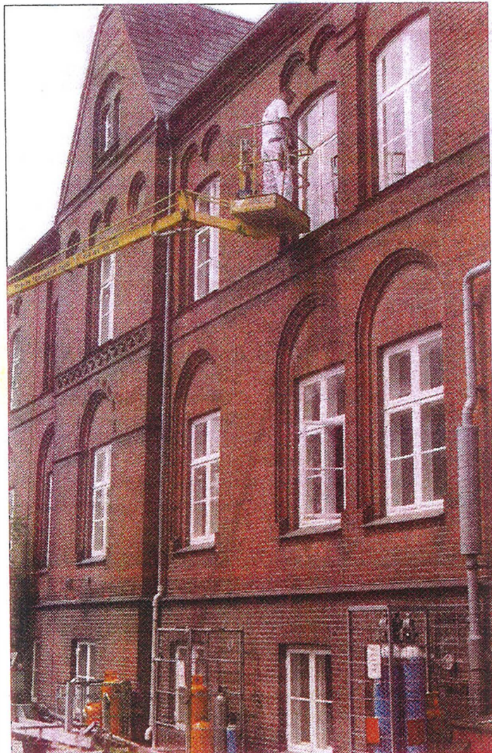
Depotgården får i disse uger og måneder de gamle originale vinduer renoveret. De er fra dengang, bygningen blev opført i 1891, og fremstillet af solidt kernetræ.
